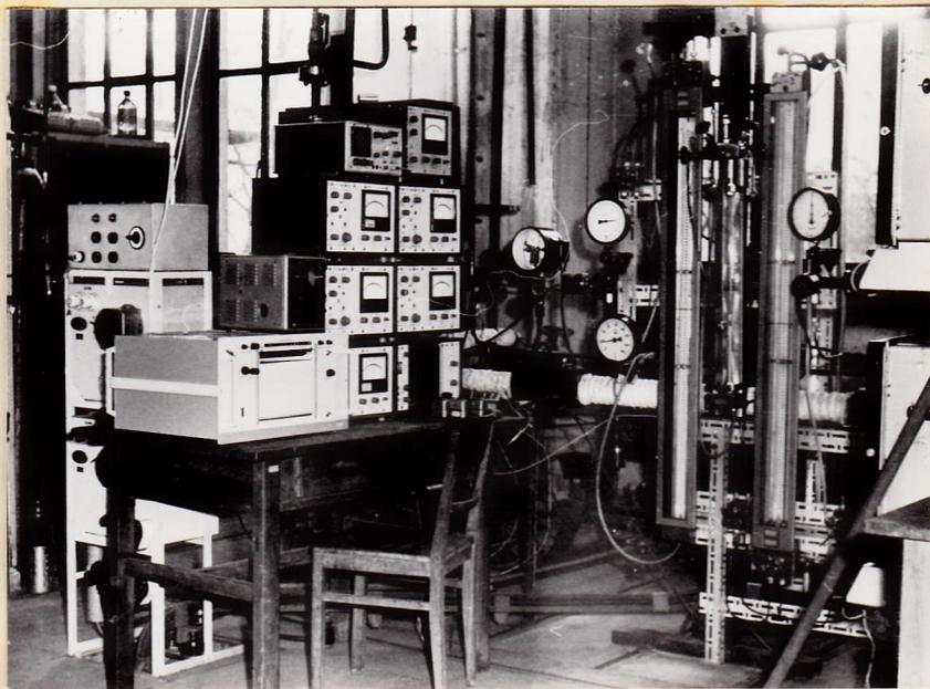
Bild 6 : Meßplatz der Versuchsanlage ( Blick auf Verstärker der Druckaufnehmer und Lichtstrahloszillograf )
